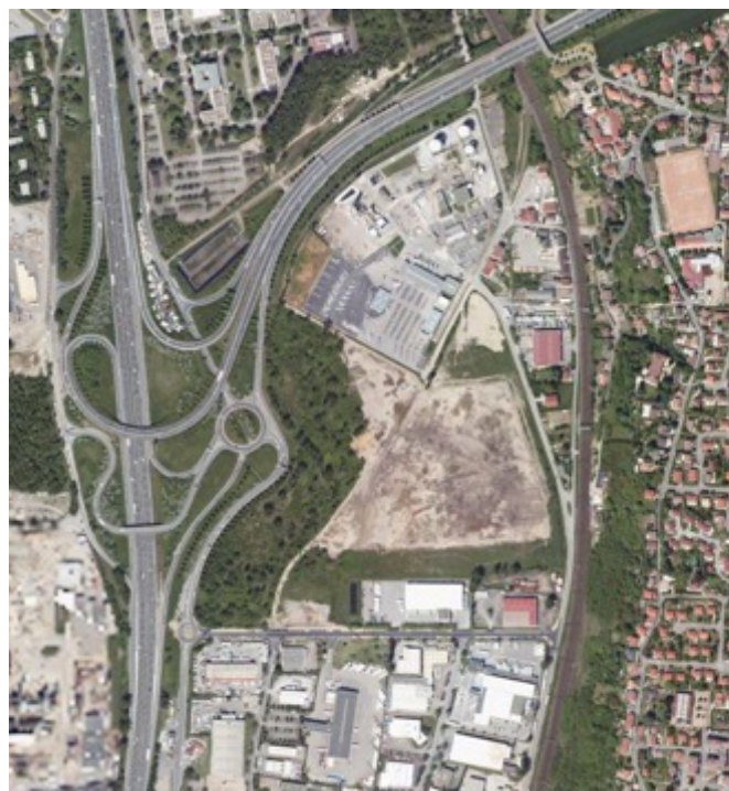
Dépôt de remblais provenant de Confluence en 2007
