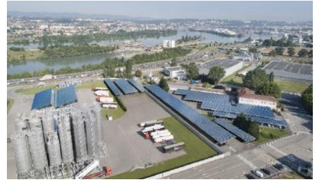
Les sites KEM ONE et VOS LOGISTICS basés à Saint-Fons ©Terre et Lac Solaire
